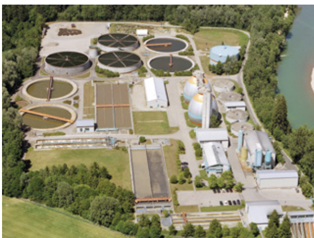
Impianto di trattamento acque reflue realizzato con componenti ENEXIO
